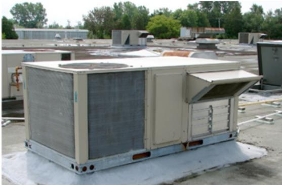
**Figure 2.1 Air Handling Unit**
